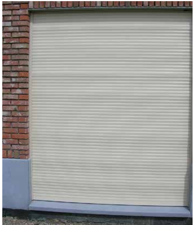
Bild 4: Welligkeit von Rollladenpanzern
